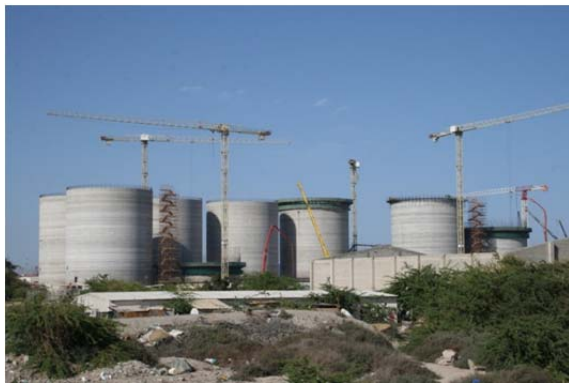
Fujairah Grain Silos - U.A.E
